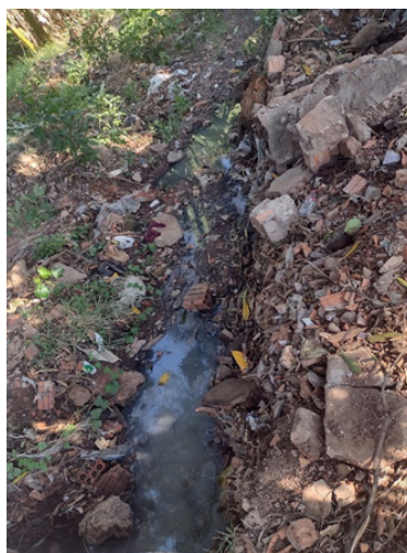
Figura 2. Esgoto sem tratamento localizado entre as casas da região
