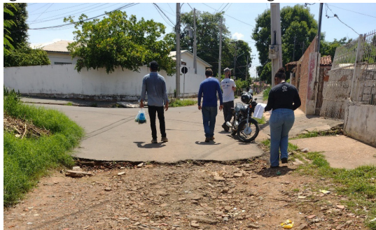
Figura 21. Fim do asfalto no Bairro Lagoa do Jacaré
