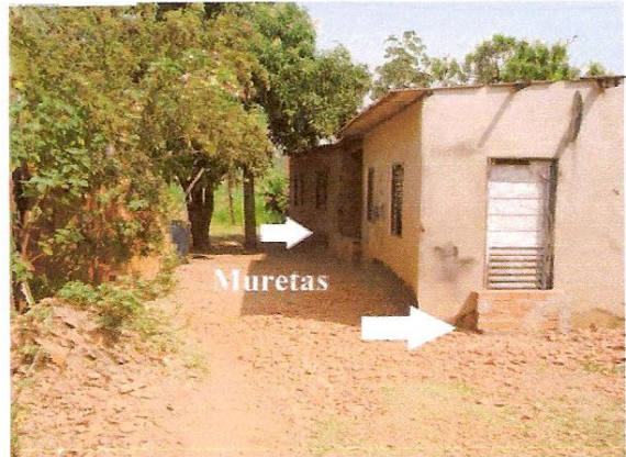
Figura 17- Construções de mureta na porta de entrada da residência, para evitar a entrada de água.
