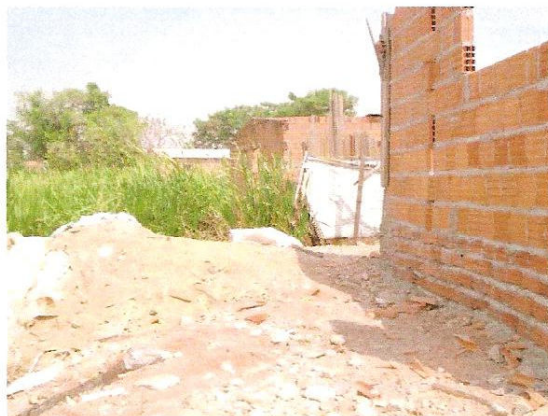
Figura 3 – Aterro com pó de serra.
