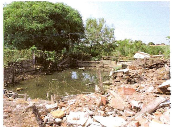
Figura 27 – Presença de água da Lagoa dentro do lote.
