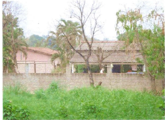
Figura 13 - parte da área ao fundo da residência - local com água.
