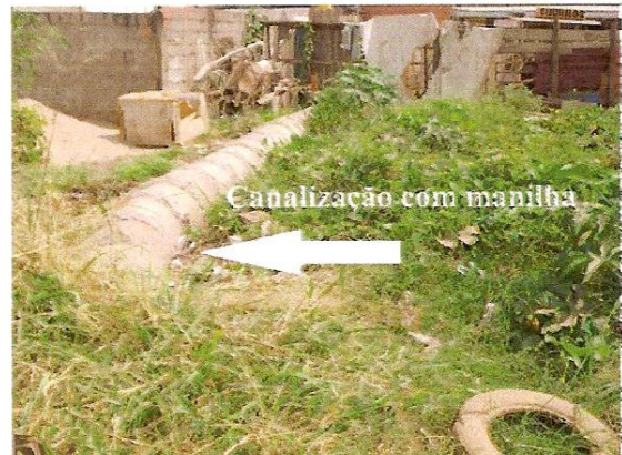
Figura 2 – Canalização de águas pluviais.
