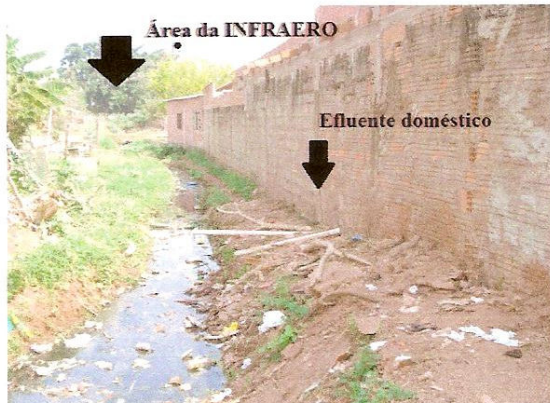
Figura 20 – Lançamentos de efluentes domésticos in natura no córrego, através de canos de pvc,.
