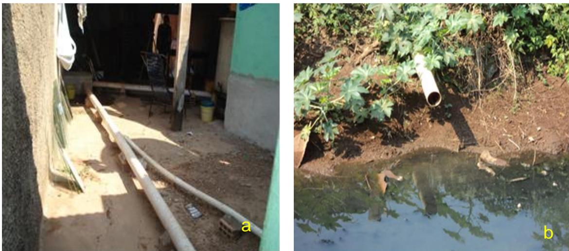
Figura 6(a e b) – Cano de pvc utilizado para escoamento dos efluentes domésticos de uma residência localizada no entorno da Lagoa do Jacaré, com destino final na lagoa.
